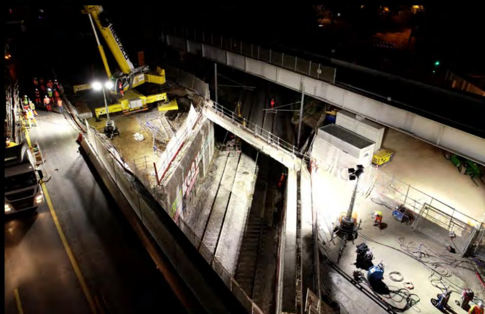
Mise en place de la charpente métallique du pont provisoire à l'aide de 2 grues de 750 tonnes chacune.
