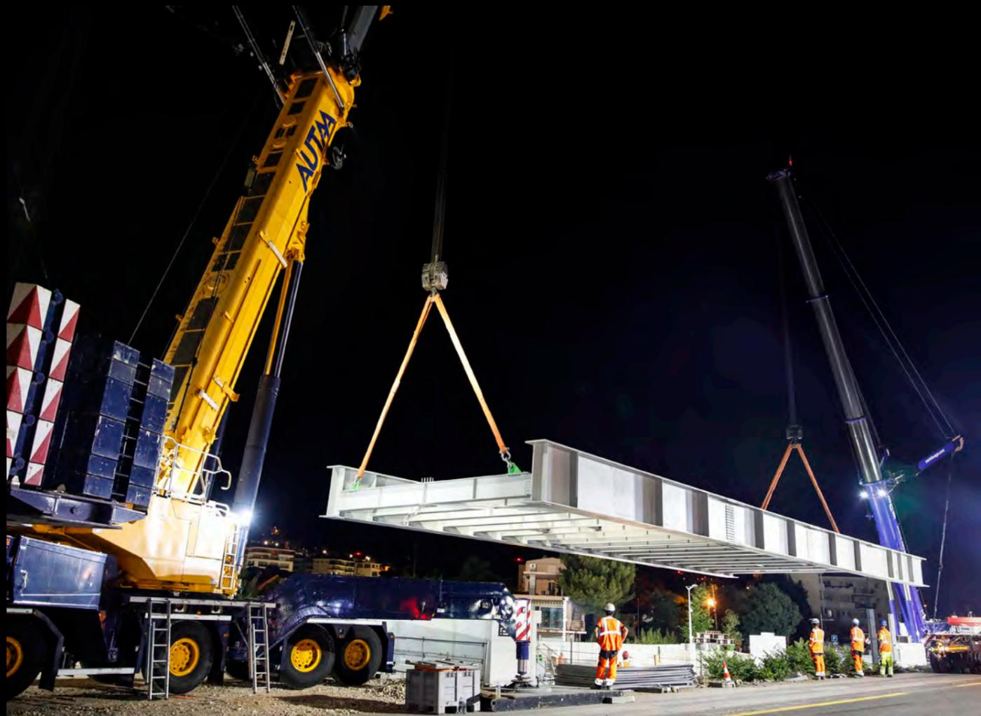
Mise en place des dalles en béton à l'intérieur de la charpente métallique. L'ensemble constitue le tablier du pont, c'est à dire la partie où circulent les véhicules.
