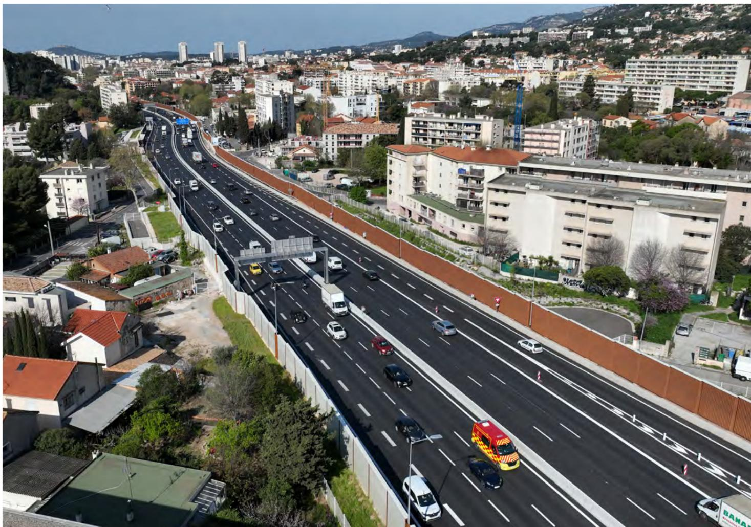
Écrans acoustiques entre l'échangeur de La Palasse et Benoît Malon.
