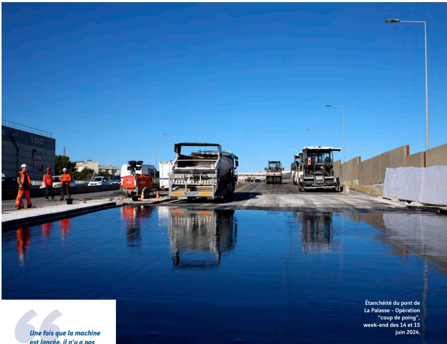
Étanchéité du pont de La Palasse - Opération "coup de poing", week-end des 14 et 15 juin 2024.
