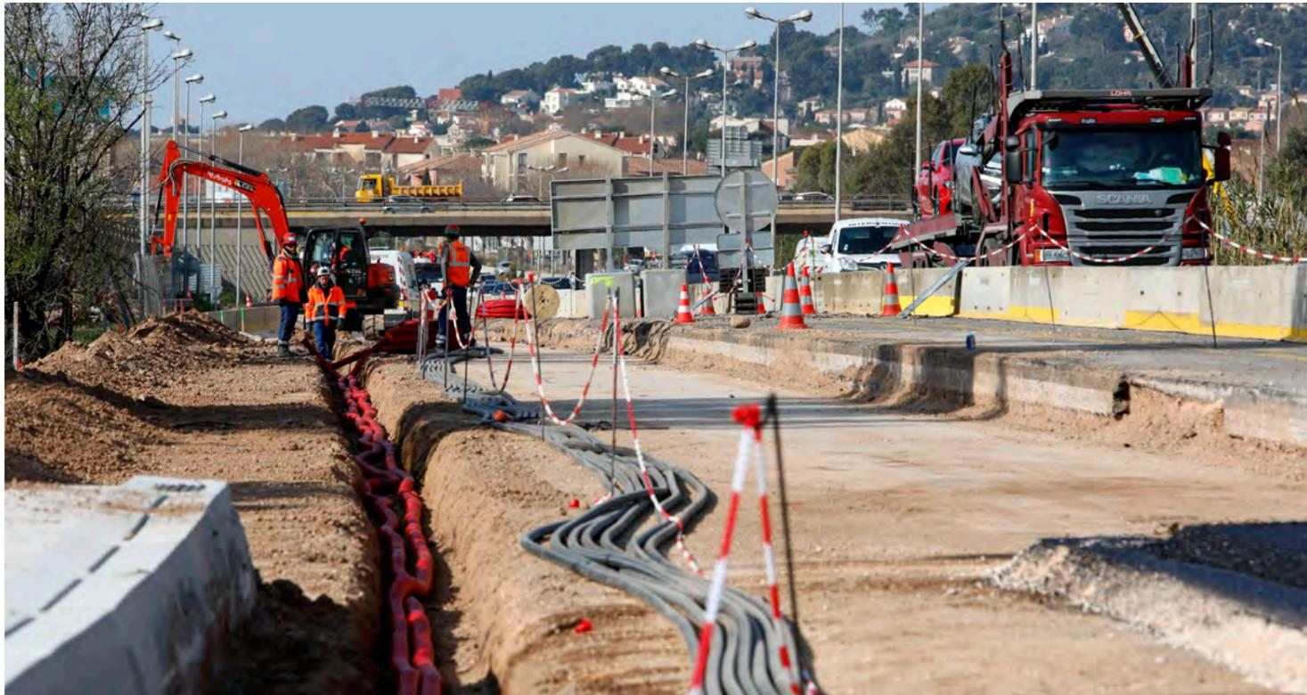
Mise en place de réseaux dans la partie élargie de l'A57.
