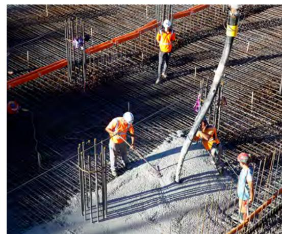
Mise en œuvre de béton bas carbone pour la création des bassins enterrés.
